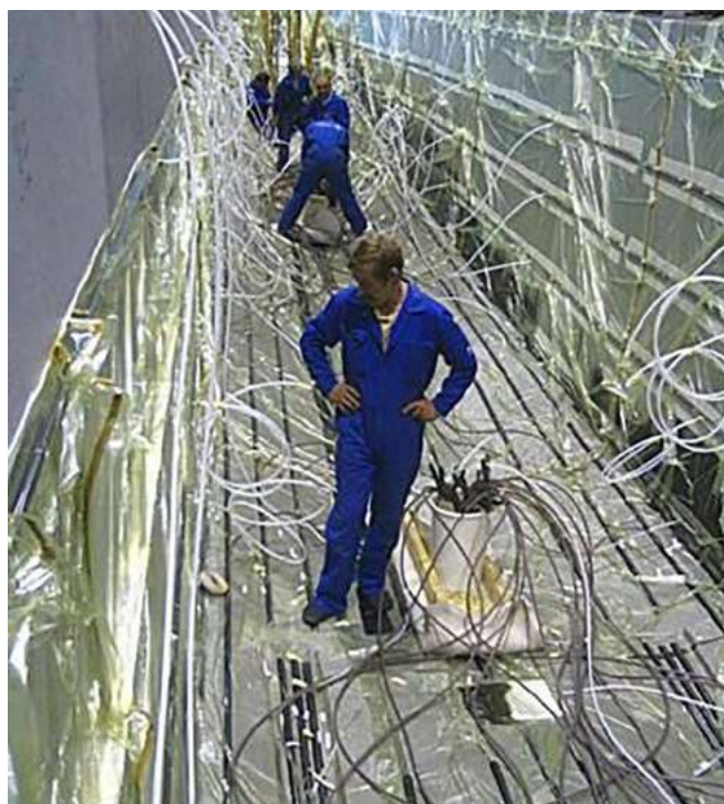
Рис. 1. Подготовка к изготовлению корпуса катамарана методом вакуумной инфузии
