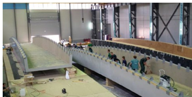
Рисунок 5. Технологический цех по изготовлению коробчатых пролетных строений методом вакуумной инфузии
