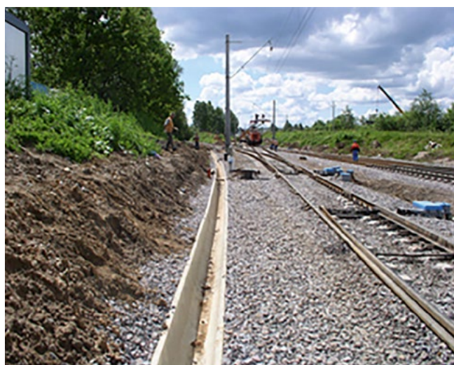
Рисунок 1. Водоотводный лоток на железнодорожной линии
