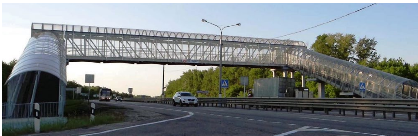
Рисунок 3. Пешеходный путепровод на трассе М-4 «ДОН» (Расчетный пролет 32.9 м). Построен в июле 2013 г.
