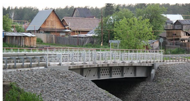
Рисунок 4. Гибридный автомобильный мост через реку Пашенка длиной 18,5 м
